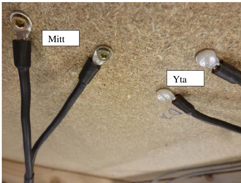
Bild 6: Montering av fuktkvotsgivare på undersidan av spånskivan. Givare som läser av i skivans mitt är monterade med ledande 12 mm långa skruvar, medan ytgivare är monterade mot ytan med plastskruv.
