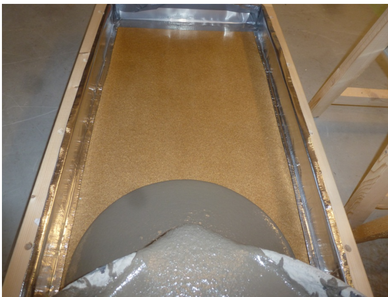
Bild 5: Avjämning sker på primad spånskiva.
